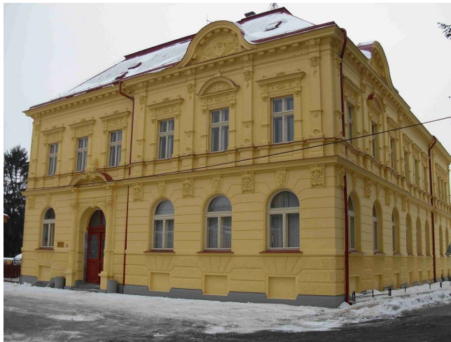
Objekt po rekonstrukci:
