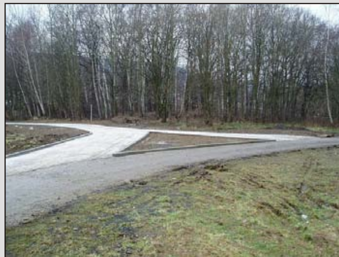
Spojovací cesta u podchodu Střelecký vrch.
