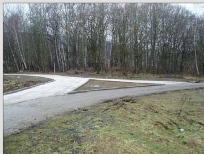
Spojovací cesta u podchodu Střelecký vrch.
