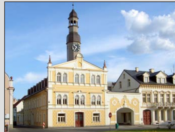
Dokončení rekonstrukce radnice.
