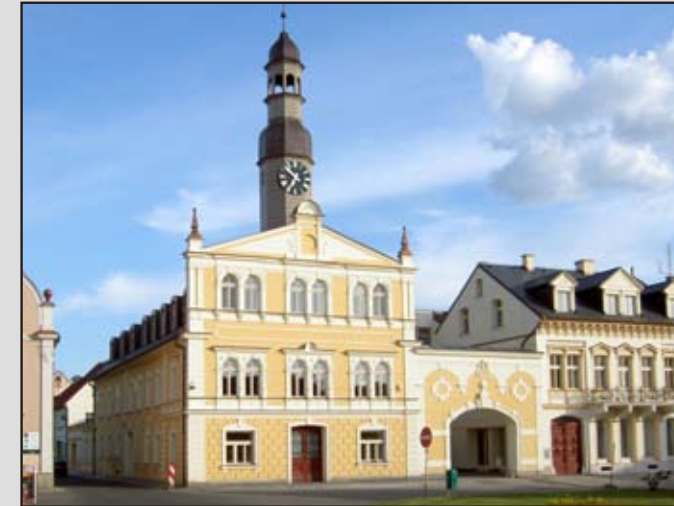
Dokončení rekonstrukce radnice.
