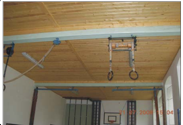
Vpravo: Strop tělocvičny byl kompletně vypalubkovan.
